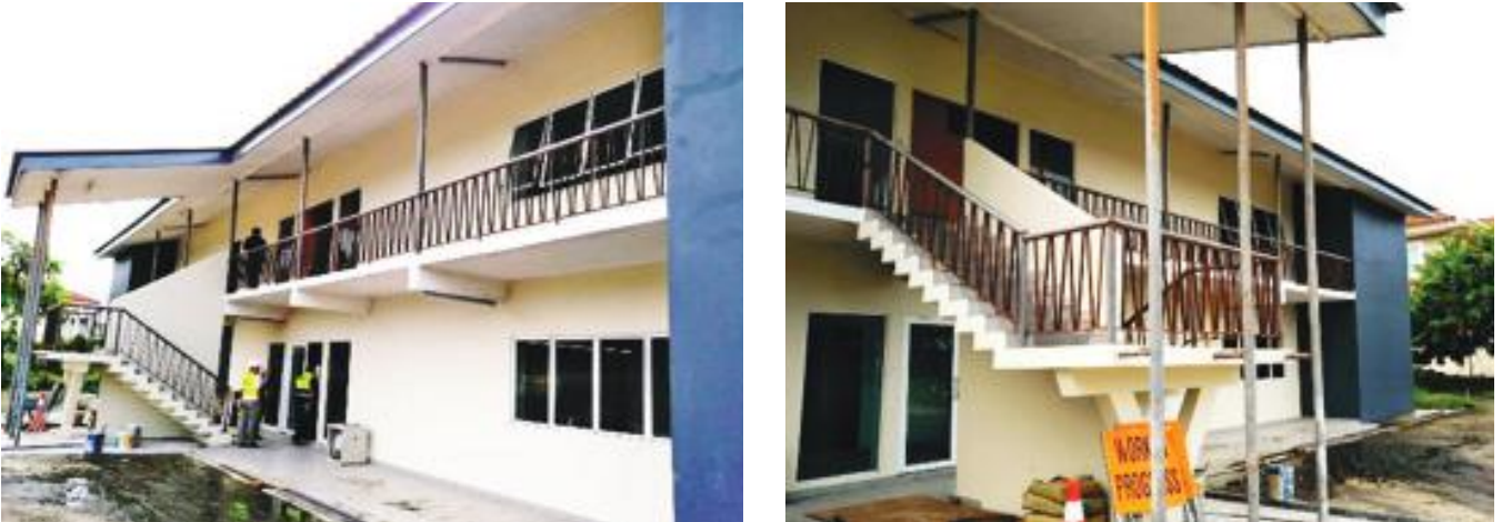
Pemandangan luar bangunan barek-barek yang sedang dipulihkan The exterior view of the refurbished barracks
